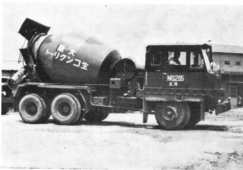
生コンミキサー車（ロケット型4.5m<sup>3</sup>積）
